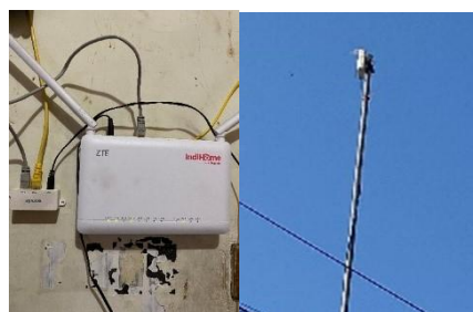
Gambar 4. Pemasangan Jalur. Modem ISP ke Router Pemancar ( Transmitter )
